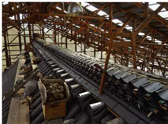
重文 仁和寺観音堂保存修理（瓦葺替）を当社が施工
