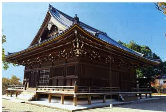
重文 仁和寺観音堂（保存修理竣工後）
